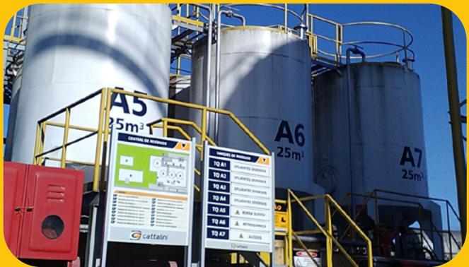
**CENTRAL DE RESÍDUOS:** Instalação destinada ao recebimento, triagem e armazenamento temporário com o objetivo de promover a separação e destinação ambientalmente adequada. A Cattalini conta com uma central de resíduos de tanques de armazenamento de resíduos líquidos.
