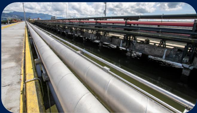
**DUTOS:** estruturas tubulares por onde escoam granéis líquidos de navios ou tanques. Podem ser aéreos (suspenso) ou subterrâneos, quando apresentam alta resistência à pressão em diferentes tipos de solo, permitindo a escoamento de líquidos com segurança. Na Cattalini Terminais, a interligação dos Centros de Tancagem com o píer é feita por 8 dutos, sendo 2 em aço carbono e 6 em aço inox, permitindo vazões de até 1.500 m<sup>3</sup>/h.
